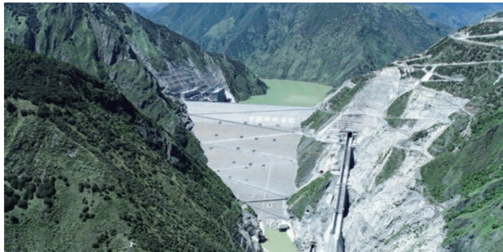
两河口水电站大坝
