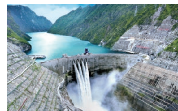
锦屏一级水电站
