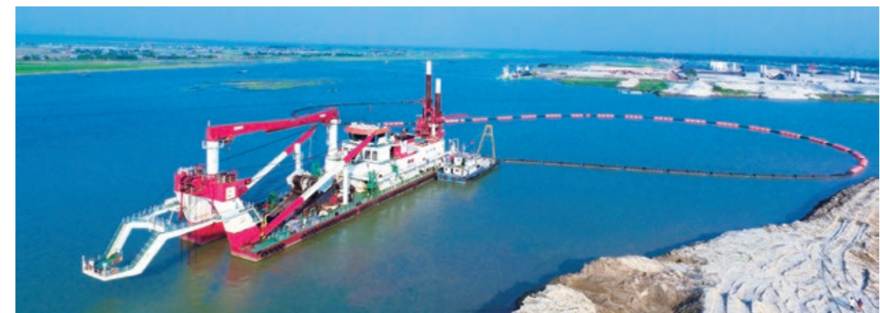
世界最大的河道整治工程——孟加拉国帕德玛河道整治项目
