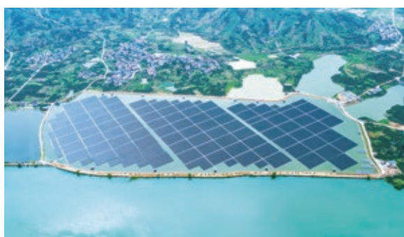
国内大型水面漂浮式光伏电站之一 ——浙江建德 20 兆瓦漂浮式光伏电站
