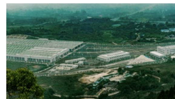
成都轨道交通 18 号线工程
