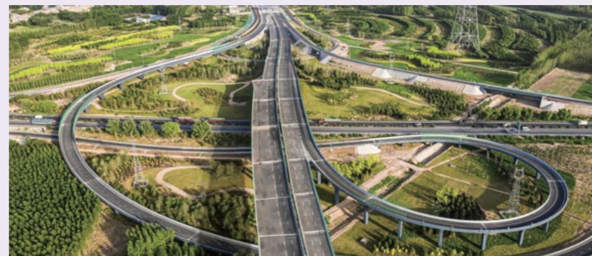
雄安新区 K1 快速路项目
