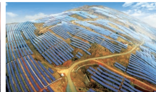
攀枝花万家山光伏电站
