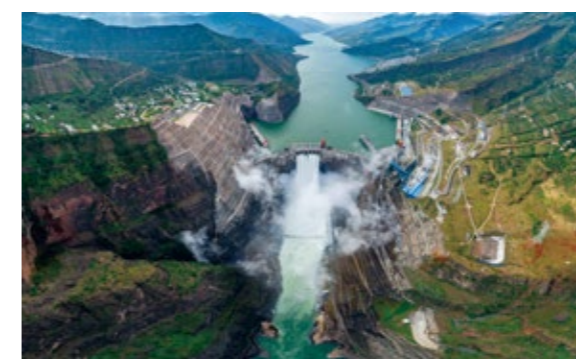
白鹤滩水电站
