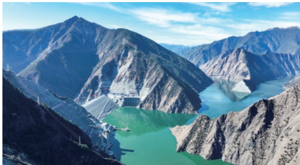
两河口水电站全貌
