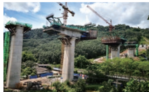
玉磨段关坪大桥连续梁施工
