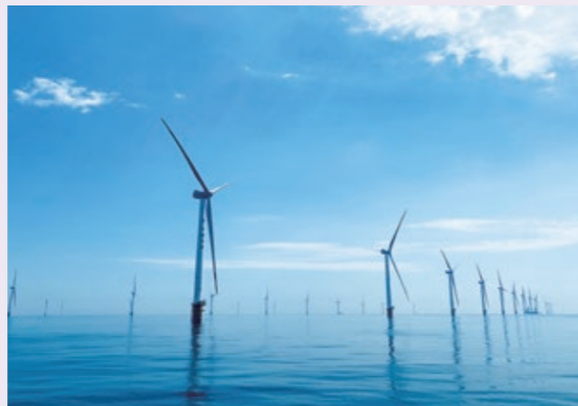
我国北方首个大型海上风电项目——大连庄河海上风电项目
