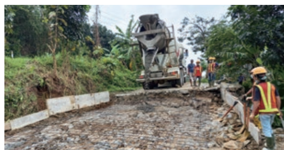
雅万高铁项目部为村民修缮道路
