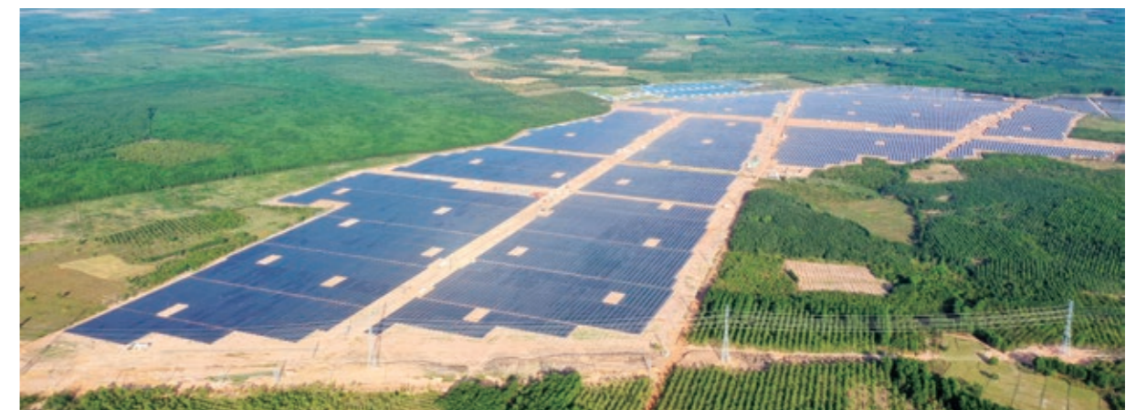
东南亚最大光伏项目——越南禄宁 550 兆瓦光伏项目
