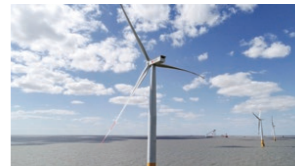
国华东台四期（H2）300 兆瓦海上风电场工程
